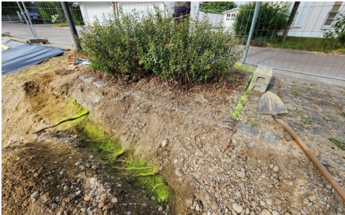
Abbildung 37 Wurzelsondierung per Handschachtung: Schaufeleinsatz. Foto: Annette Hartmann, 2025.
